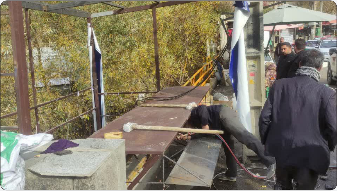
جمع‌آوری سازه سبک احداث‌شده روی رودخانه گنجنامه و رفع سد معبر
